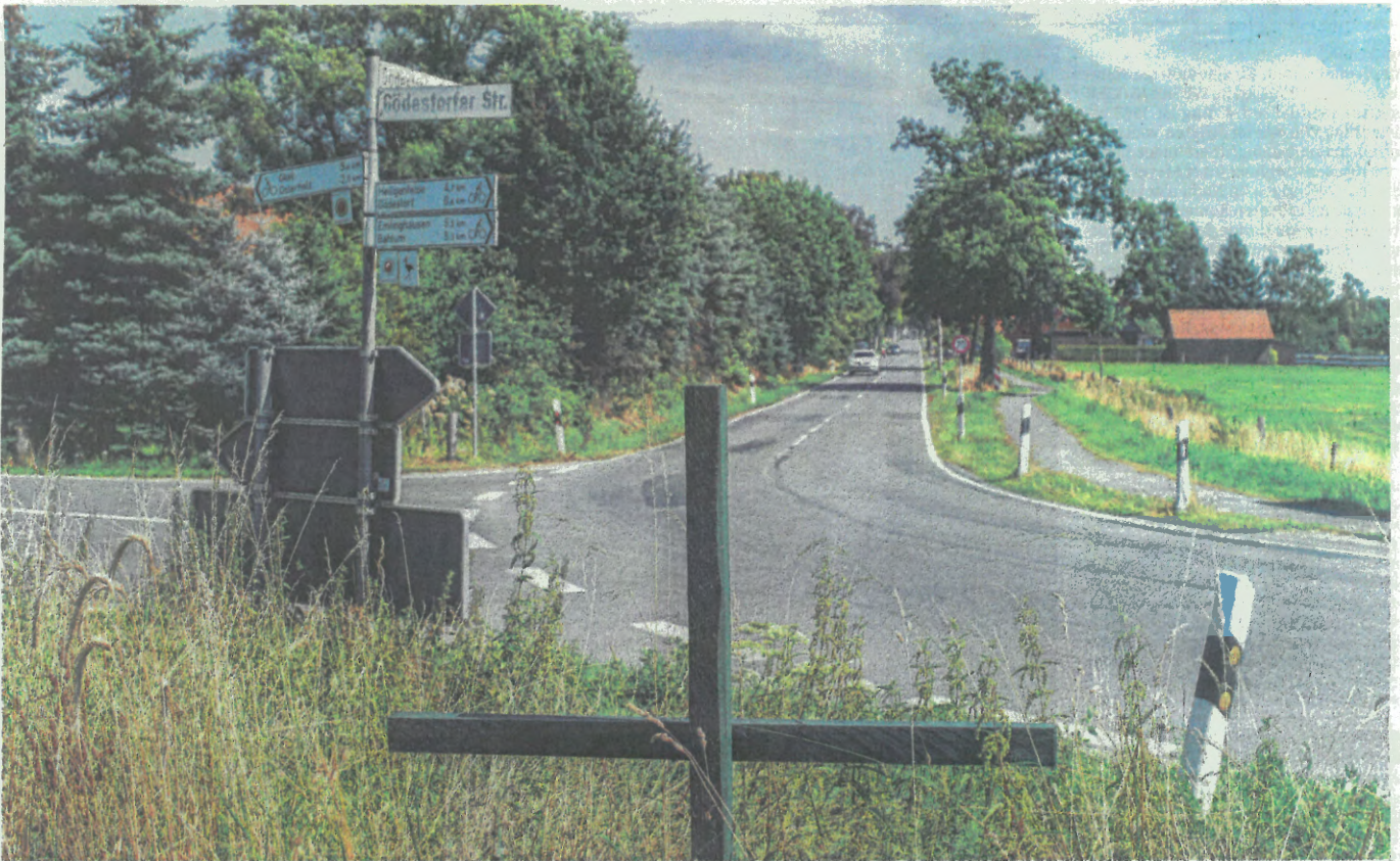
An der Einmündung der Gödestorf Straße (Kreisstraße 74) auf den Gödestorfer Damm (Landesstraße 354) kommt es immer wieder zu Unfällen. Daher soll dort nun etwas passieren. Möglich wäre ein Kreisel.
