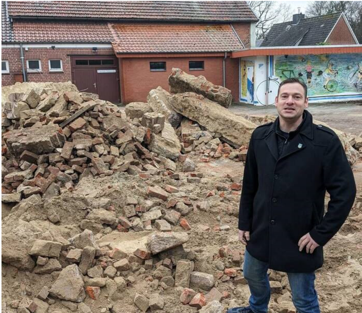
Barriens Ortsbürgermeister Christian Eilers steht vor den Trümmern der Barrier Butze. In dem Jugendhaus (und seinem Vorgänger-Gebäude) haben Generationen von Barrier Jugendlichen ihre Zeit verbracht. Der Abriss des Gebäudes steht nach Eilers' Einschätzung ein Stückweit sinnbildlich für die kommunale Jugendarbeit in Barrien. Foto: Frank Jaursch
